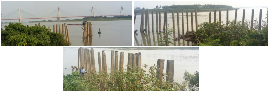
Hình 5. Hình ảnh các cọc BTCT tại các cụm kè KT10+11, KT1, KT2 thuộc tuyến kè Tầm Xá
