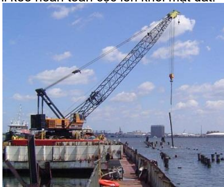
Hình 3. Hình ảnh nhổ cọc bằng cần cẩu đặt trên ponton [5]
