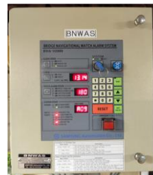
Hình 5. Bảng điều khiển hệ thống BNWAS trang bị trên tàu VMU Việt-Hàn
