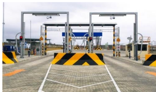
Hình 6. Hệ thống cổng tự động nhận diện container và xe tải bằng hệ thống OCR
