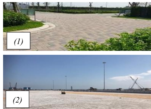
Hình 7. (1) Gạch tự chèn cho khu vực đường nội bộ - (2) Gạch bê tông mác 600Mpa, chiều dày 12cm cho đường trong cảng Cái Mép-Gemalink
