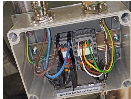
Hình 7. Lắp đặt hộp đầu dây trung gian
