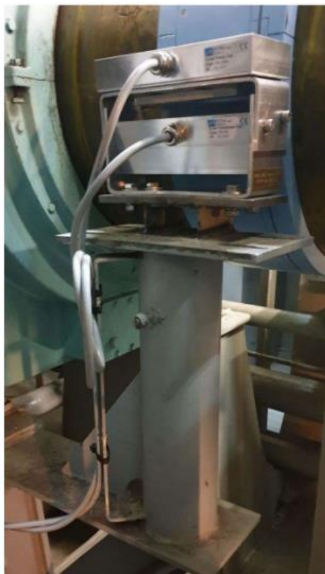
Hình 8. Lắp đặt cảm biến trên trục động cơ máy chính
